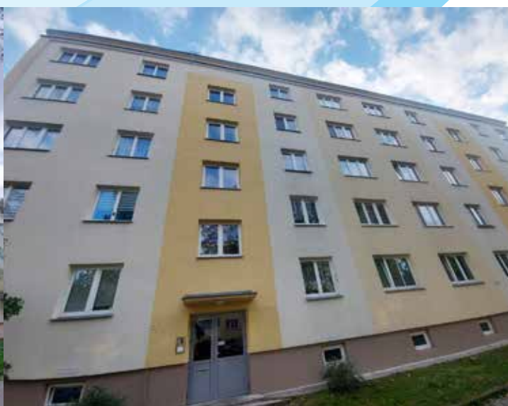
Fasáda bytového domu po kompletnej dezinfekcii a následne jej naimpregnovaní
