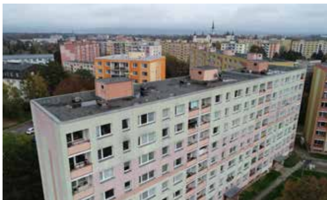
Stávající stav ploché střechy před rekonstrukcí a se záměrem budoucí instalace FVE
