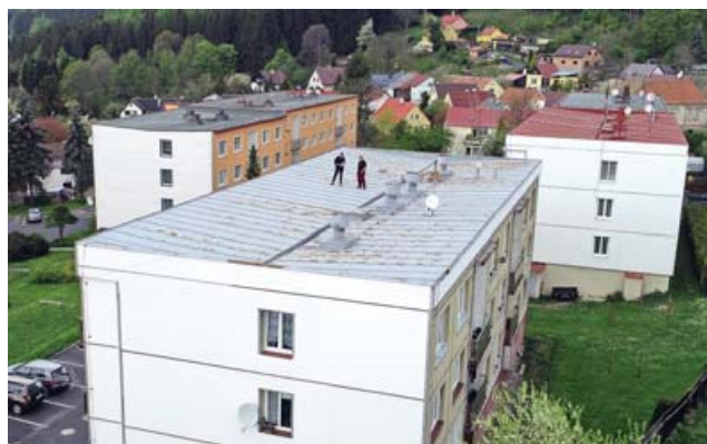
Oprava vytvořením nové ploché střechy nad stávající
