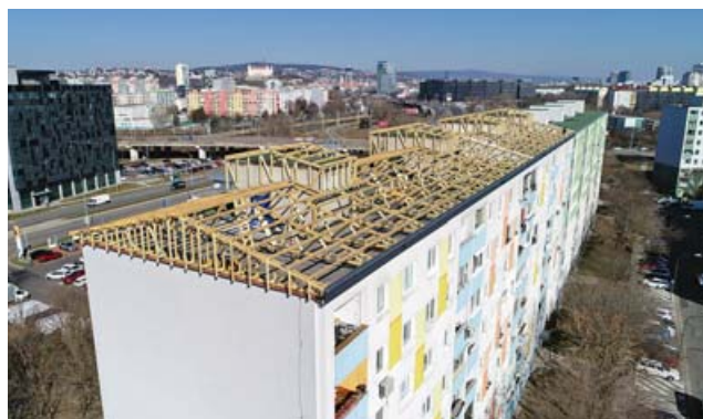
Dřevěná nosná konstrukce
