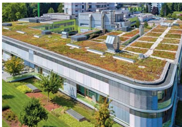
Obr. 6 Príklad extenzívnej vegetačnej strechy [5]
