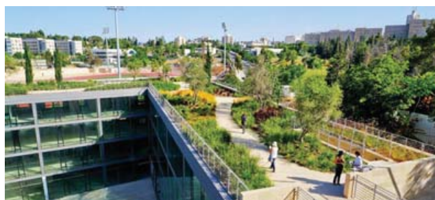
Obr. 7 Príklad intenzívnej vegetačnej strechy a s aktívnym využitím [6]
