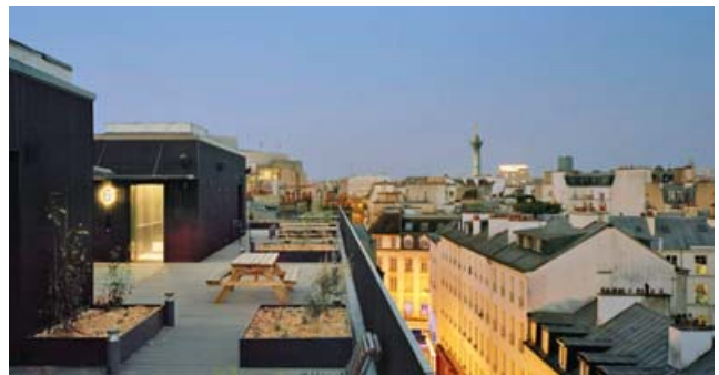
Obr. 10 Príklad využitia plochej strechy ako terasy avšak bez tienenia a s minimálnou prítomnosťou zelene. Tmavé povrchy stien budú navyše výrazne absorbovať slnečné žiarenie, čo povedie k vysokej povrchovej teplote, ktorá následne bude sálať teplo na okolie a samozrejme aj návštevníkov terasy – tepelný diskomfort [9]
