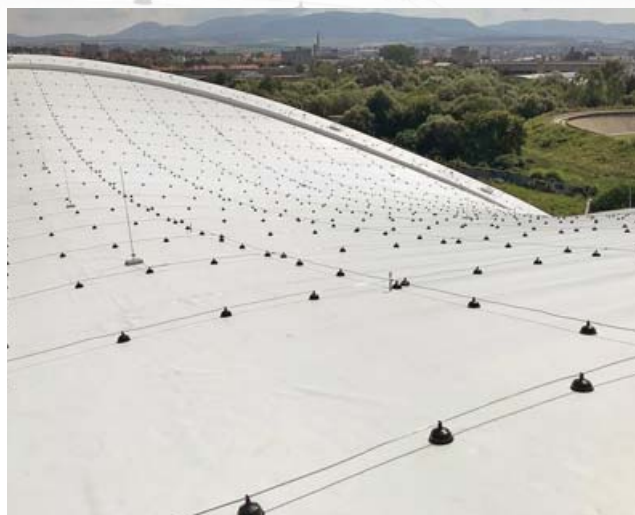
Zimný štadión Prešov má svoju netradičnú hyperbolickú strechu renovovanú novou TPO fóliou BMI EverGuard na ploche 6600 m 2 . Tá svojimi reflexnými vlastnosťami pomáha izolovať interiér pred prehriatím
