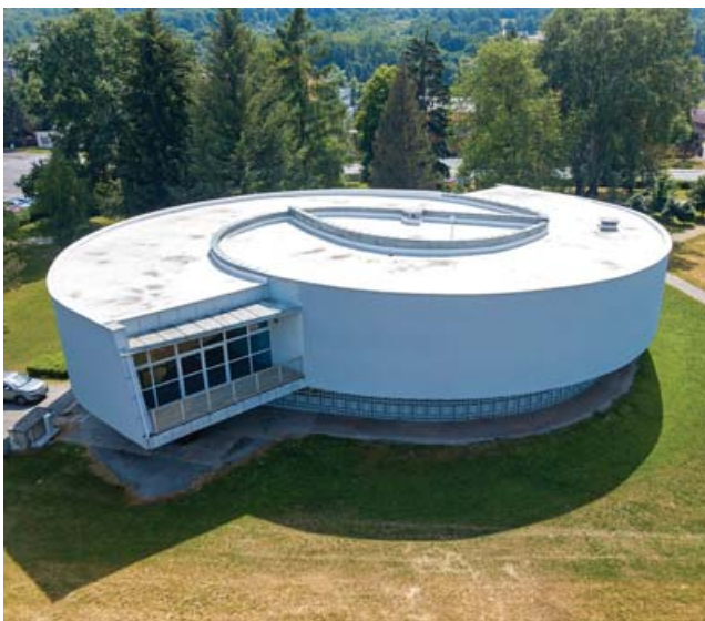
Zimný štadión Prešov má svoju netradičnú hyperbolickú strechu renovovanú novou TPO fóliou BMI EverGuard na ploche 6600 m 2 . Tá svojimi reflexnými vlastnosťami pomáha izolovať interiér pred prehriatím
