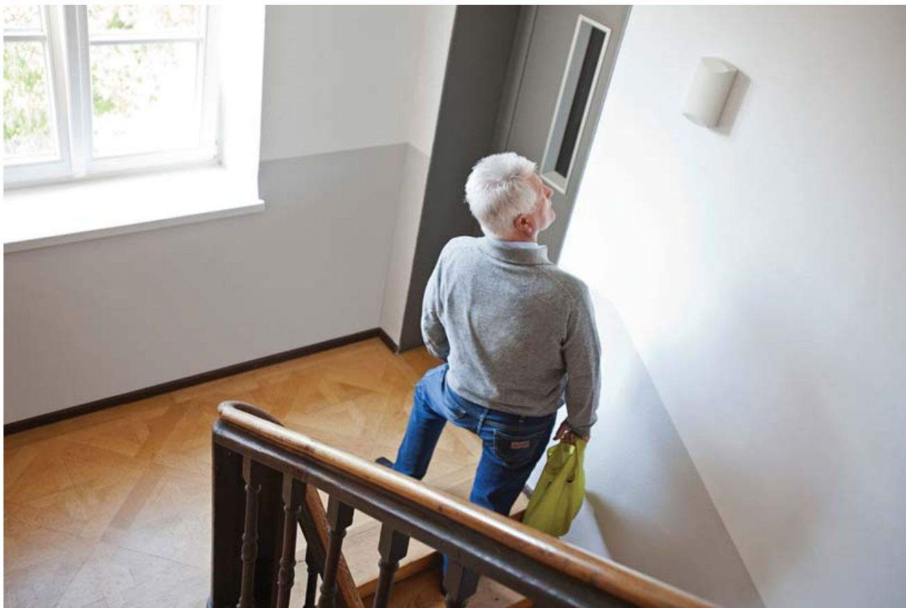
Zbernica dát sa inštaluje v spoločných priestoroch budovy a jej funkčnosť je monitorovaná. Zdroj: ista Slovakia
