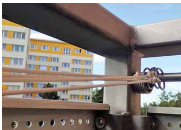
Obrázek 3 Detail připojení rohového sloupku k madlům balkonu
