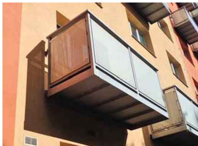
Obrázek 2 Detail zavěšeného balkonu
