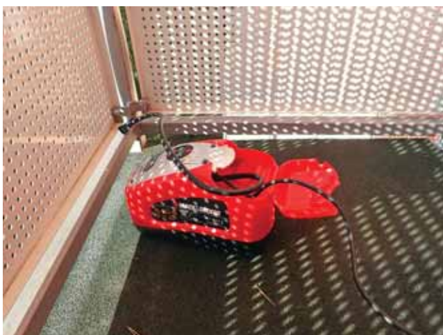
Obrázek 9 Natlakování konstrukce balkonu kompresorem na 2 atp.
