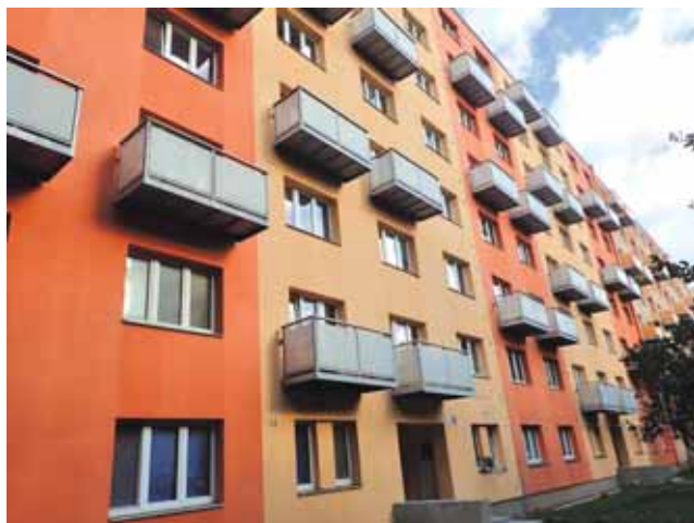
Obrázek 1 Obytný dům se zavěšenými balkony
