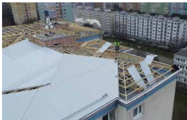
Obr. 6: Montáž trapézového plechu
