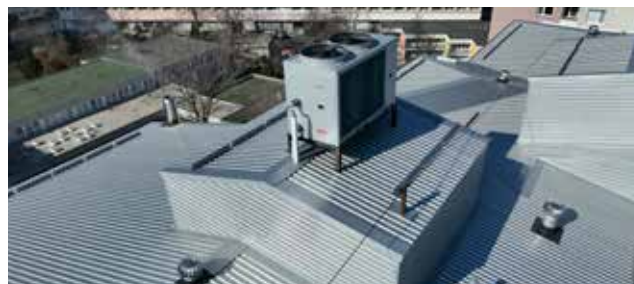
Obr. 3: Nové tepelné čerpadlo - ocelová konštrukcia dodaná firmou Strechy 92
