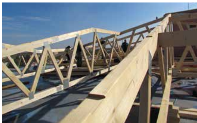
Obr. 4: Opracovanie nosnej konštrukcie pre urýchlenie montáže
