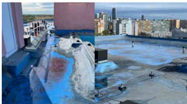
Obr. 2: Pôvodný stav strechy – tvorba kaluží kvôli nesprávnejmu vypádovaniu strechy
