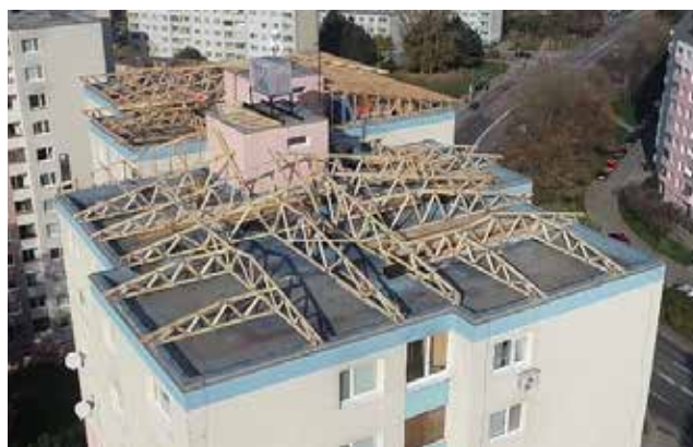
Obr. 5: Nosná konštrukcia pozostávajúca zo 40 druhov väzníkov
