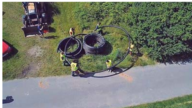
Obr. 6 Plastové predizolované potrubia NRG FibreFlex Pro pre projekt Dukovany
