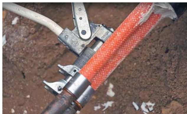
Obr. 7 Ukážka lisovania pri dvojrúrkovom systéme
