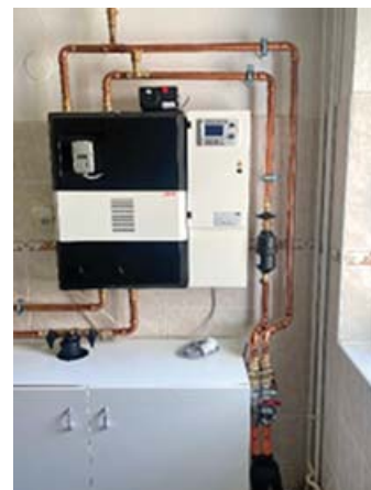
Obr. 3 Výmenníková stanica tepla PewoCompact ECO I-U1-P
