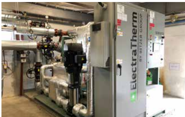
125kW PtG, instalace horkovodního ORC v režimu kogenerace – Veolia Polsko
