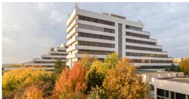
Najväčšia inštalácia IQRC systému - Fakulta elektrotechniky a informatiky, Slovenská technická univerzita v Bratislave
