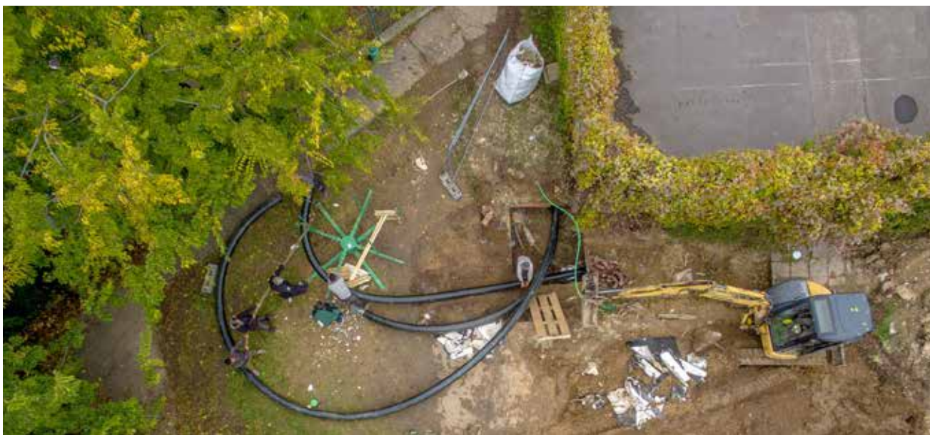
Nasúvanie plastových predizolovaných potrubí do existujúceho kanála
