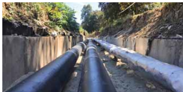
Obr. 2 Ukážka teplovodného kanála – dosluhujúce potrubie TV a cirkulácie a nové ocelové predizolované potrubie na hlavnej trase
