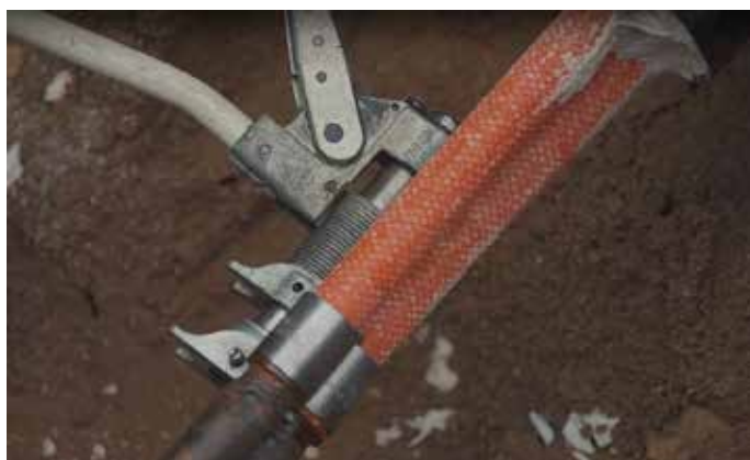
Obr. 2 Lisovanie spojov bez expanzie potrubí pri plaste
