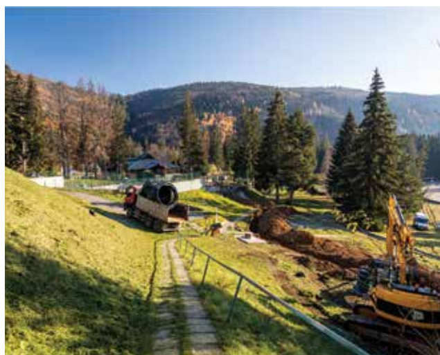
Obr. 4 Výkopové práce pre tepelné rozvody objektov
