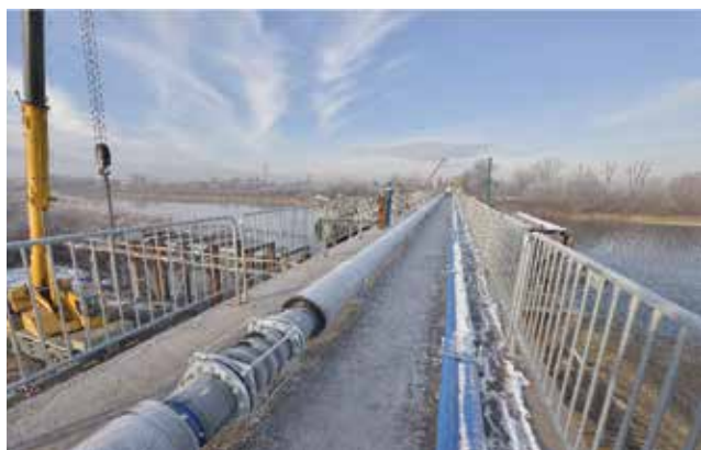
Obr.4 Aplikácia NRG UV PROTECT COLOR v zimnom období počas mrazivých dní
