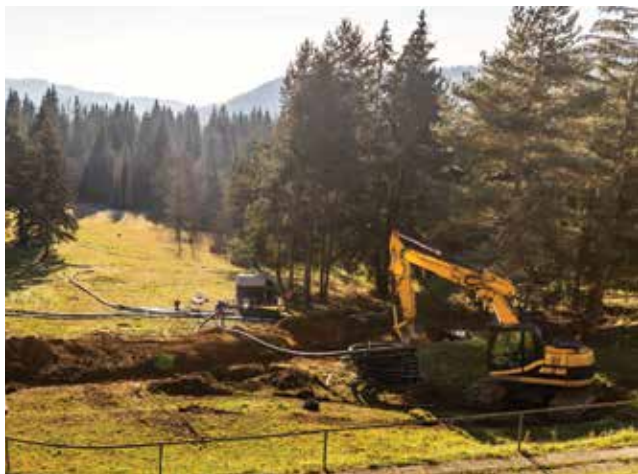
Obr. 2 Napojenie objektov pre vykurovanie
