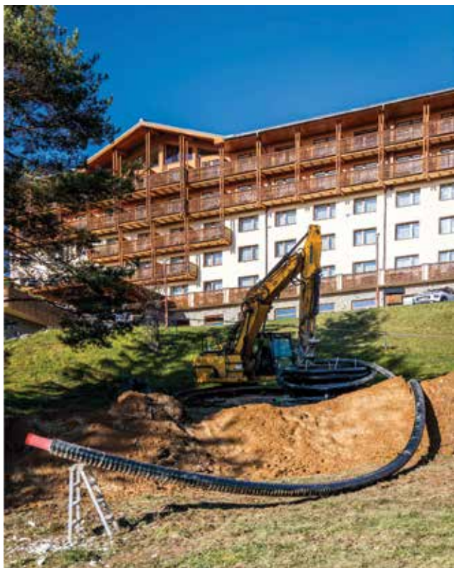
Obr. 1 Realizácia tepelných a chladiacích rozvodov hotela Partizán
