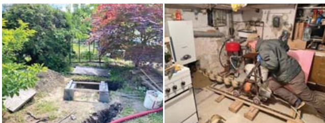
Obr. 1 Základy pod TČ a za ním jama s potrubím privedeného z pivnice cez dieru vyvŕtanú špirálou cez stenu v pivnici
