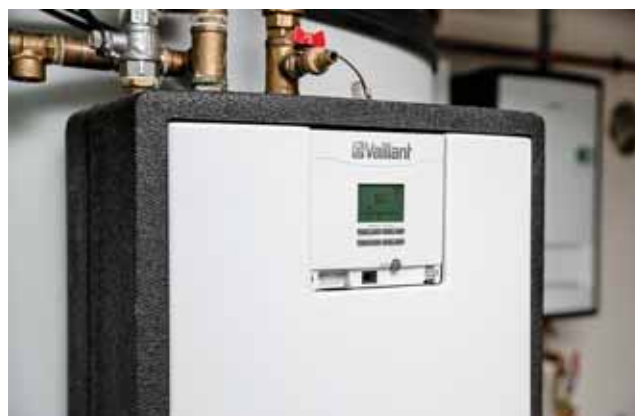
Detailný záber na modul, ktorý je na vrstvenom akumulacnom zásobníku
