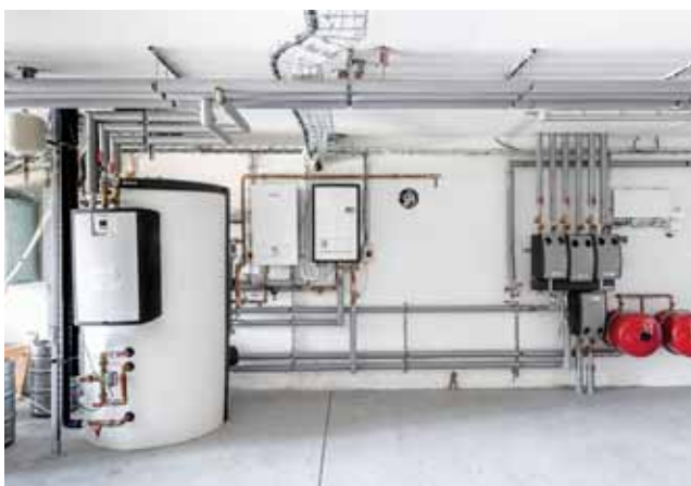
Pohľad do technickej miestnosti v pútnickom dome
