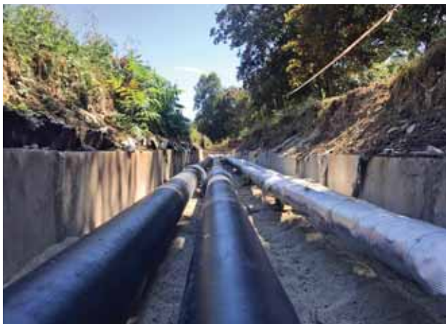
Obr. 2 Ukážka teplovodného kanála – dosluhujúce potrubie TV a cirkulácie a nové ocelové predizolované potrubie na hlavnej trase
