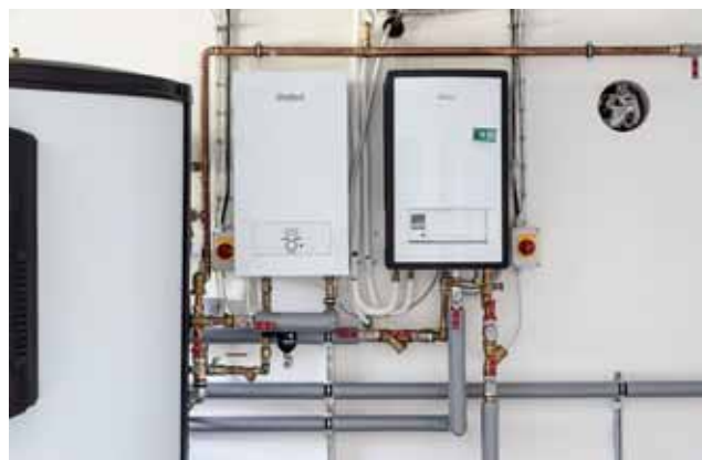
Vrstvený akumulacný zásobník, elektrokotol a hydroblok
