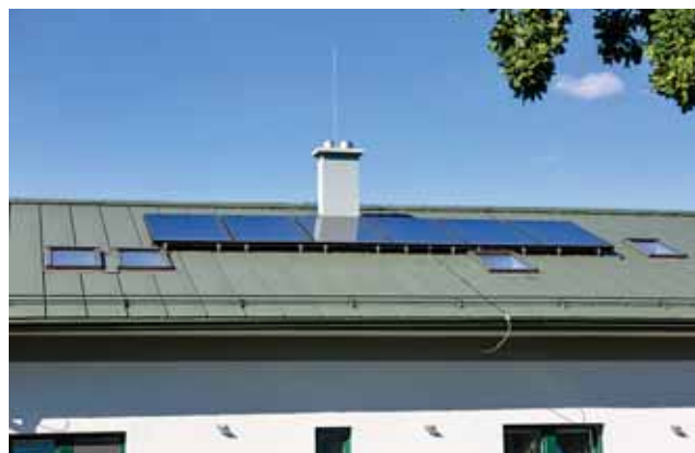
Šesť vertikálnych solárnych kolektorov na streche objektu
