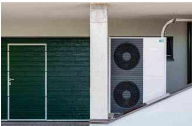
Splitové tepelné čerpadlo typu vzduch/voda
