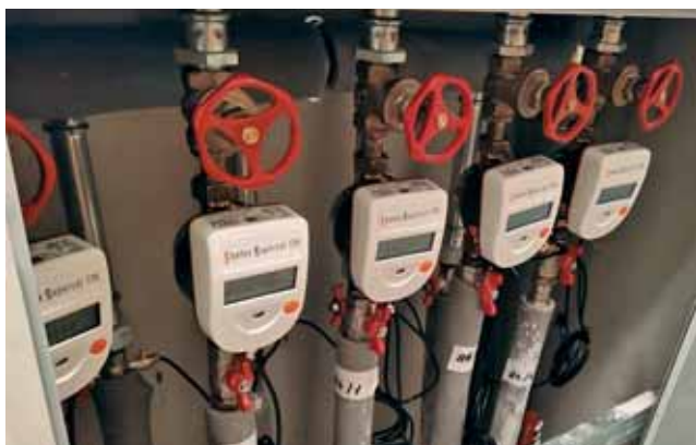
Obrázok 2 Rozvádzač s osadenými meračmi tepla s komunikačným rozhraním LoRa WAN
