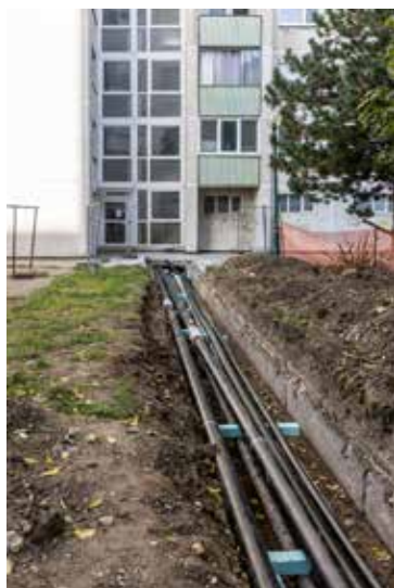
Obr. 2 Výmena rozvodov tepla Bratislava Petružalka foto: Miroslav Pochyba - JAGA
