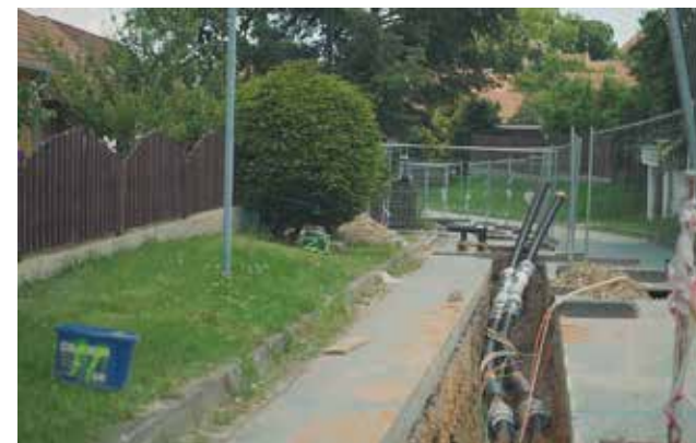
Obr. 4 Výkopové práce v obci Dukovany
