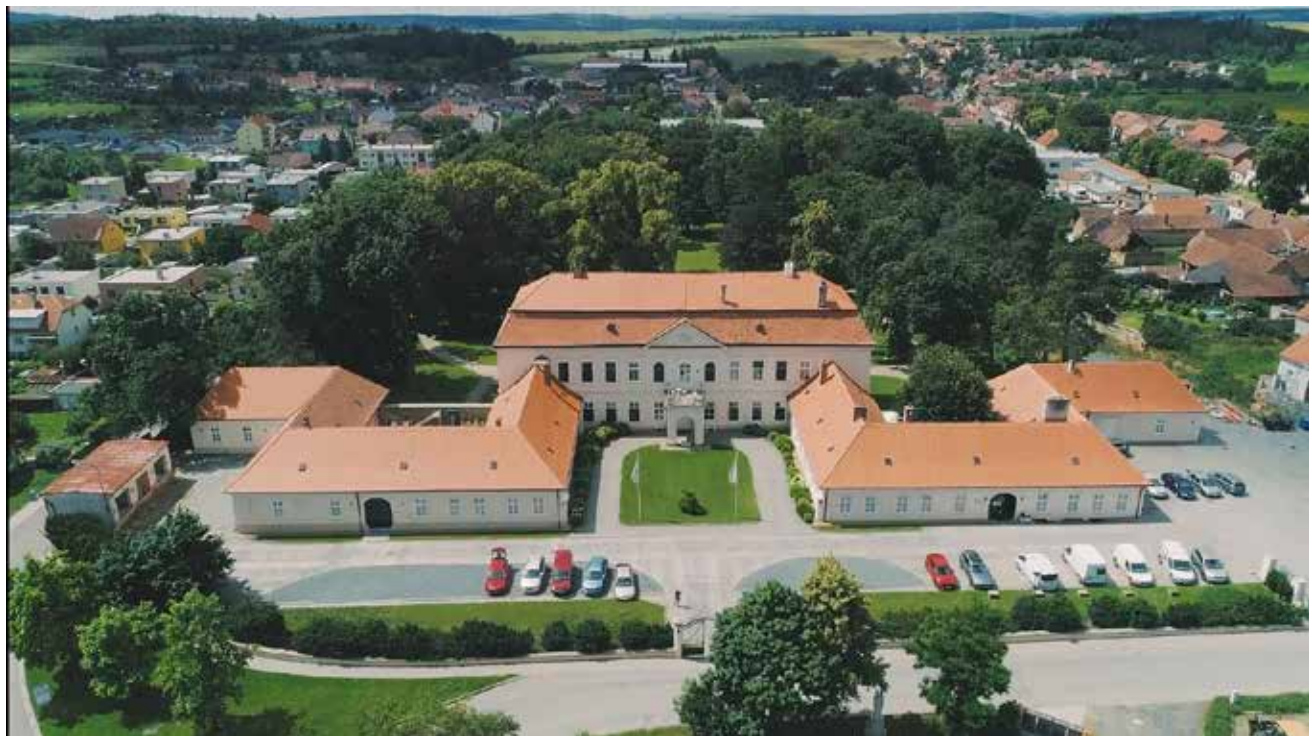
Obr. 6 V Dukovanech sú napojené plastové potrubia NRG FibreFlex Pro
