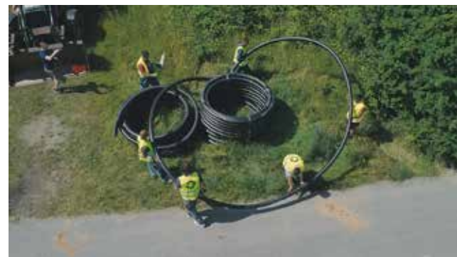
Obr. 3 Flexibilné predizolované potrubia NRG Flex
