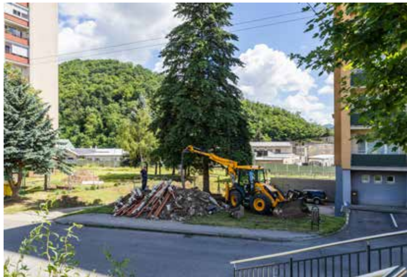
Obr. 4 – rekonštrukcia tepelných rozvodov CZT Nová Baňa
