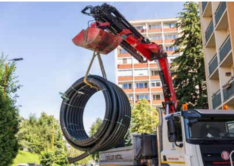
Obr. 3 – vykládka potrubia NRG HeatFlex
