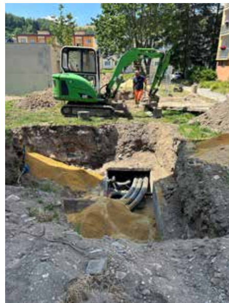
Obr. 6 Realizácia tepelných rozvodov ÚK a TUV v meste Kraslice
