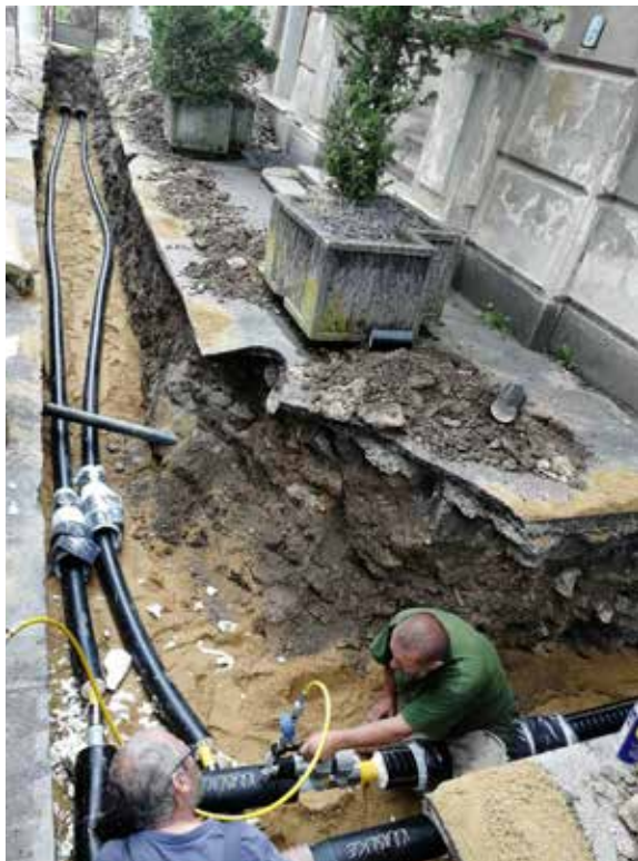
Obr. 4 Fotografia z realizácie prípojky v meste Kraslice
