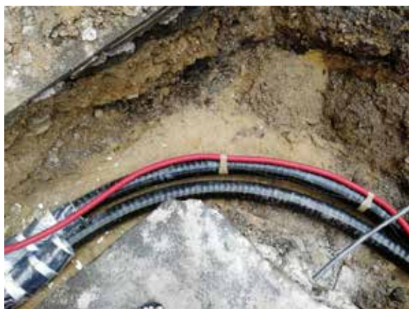
Obr. 5 Ohyb plastových predizolovaných potrubí
