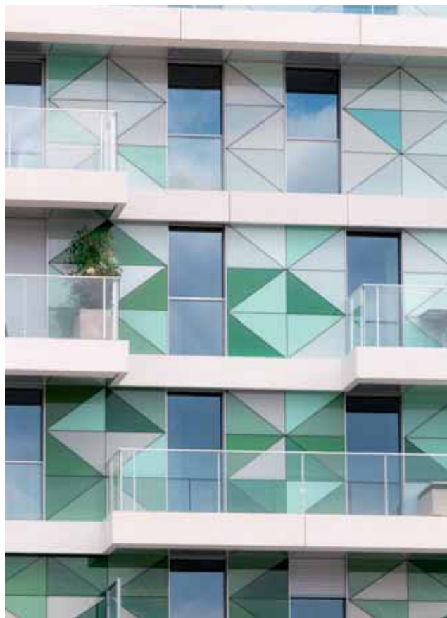
Bytový dom vo Francúzsku s fasádou, kombinujúcou kontaktný zatepľovací systém StoTherm Classic, predsaďený prevetrávaný zatepľovací systém StoVentec Glass, zložený zo sklenených panelov rôznych tvarov a biely fasádny povrch StoSignature
