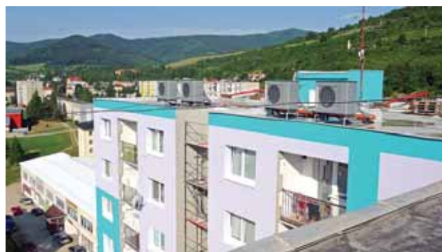
Obr. 4 Pohľad na tepelné čerpadlá vzduch/voda F2300-20
