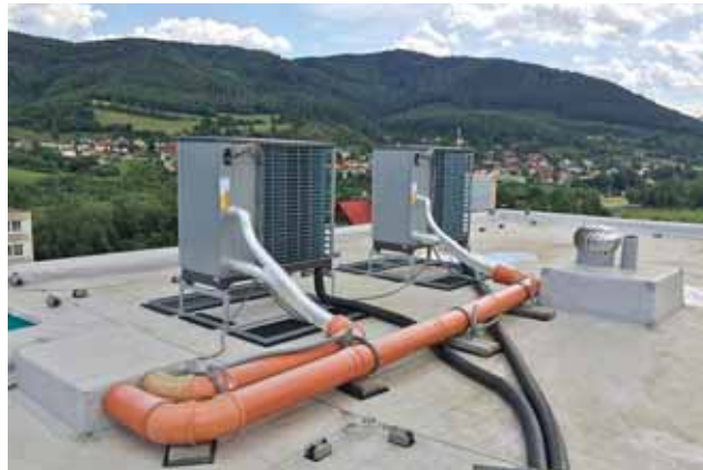
Obr. 2 Vonkajšie jednotky TČ vzduch/voda umiestnené na streche
