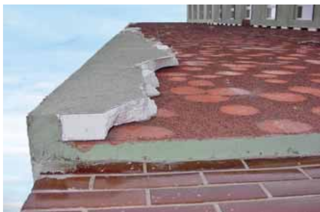
Odrhnutý izolant, chybná aplikácia
