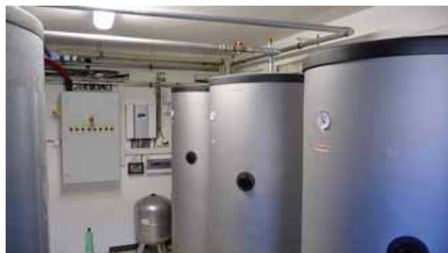
Obr. 5 Strojovňa – pohľad na zásobníky TV, reguláciu SMO 40 a elektro rozvodňu
