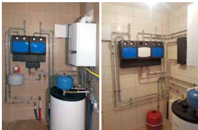
Obr. 1 a 2 Kotolne zostavené z čerpadlových modulov PASM a PAS od spoločnosti Watts Industries
